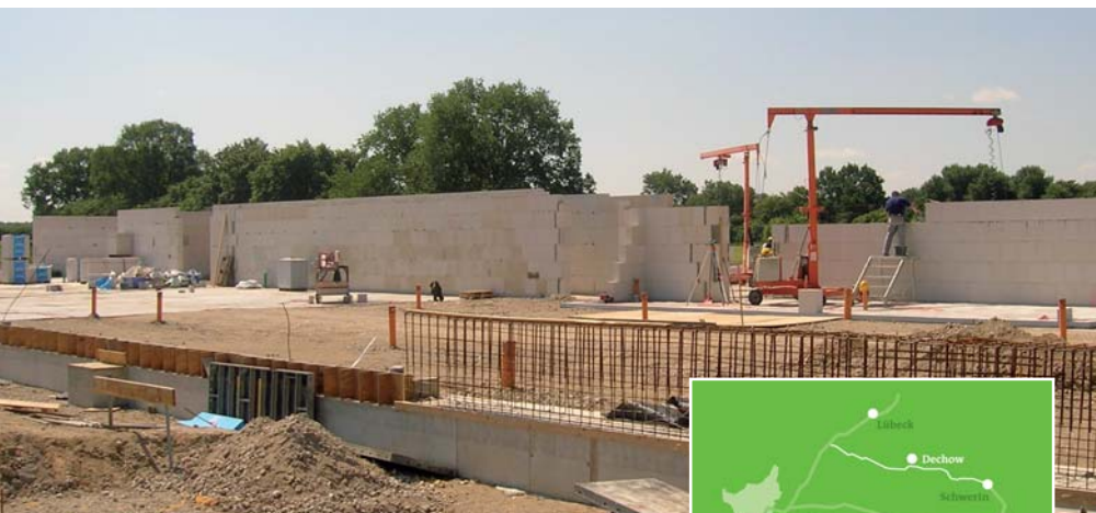
Massive Wände im Bereich der Produktion
