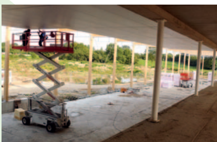
Installation der Deckenpaneele im Bereich der Milchabfüllung.
