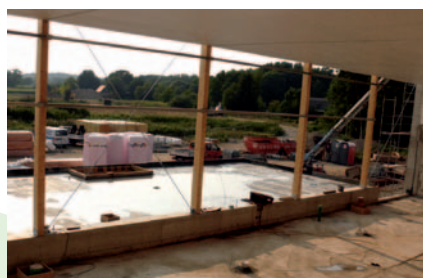
Blick auf das Milchtankfundament.
